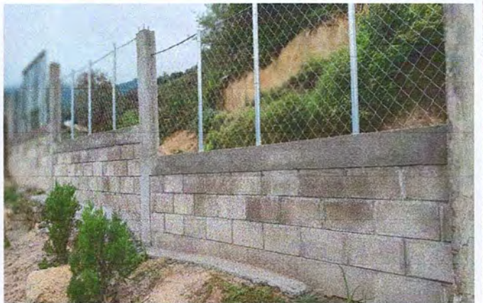
Foto 4: FINALIZACIÓN DE CERCO PERIMETRAL
