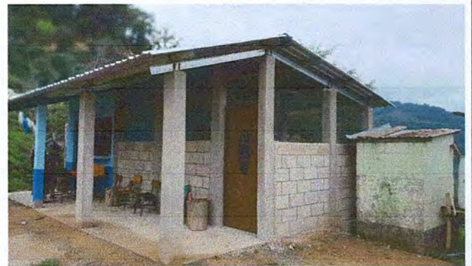
Foto 2: FINALIZACIÓN DE LA COCINA
