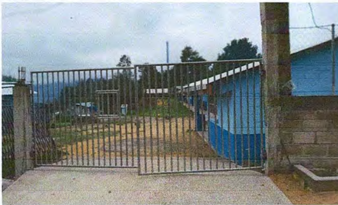
Foto 1: FINALIZACIÓN DEL PORTÓN
